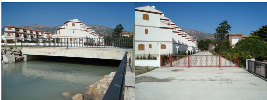
Figura 0.2 Desembocadura del barranc de la Porrassa cobert per vial d'accés a vivendes
